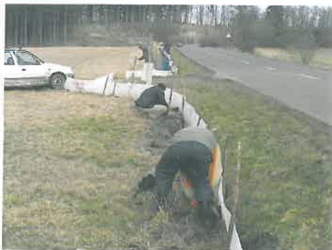
Instalace plastové fólie a zakopávání odchyťových věder.
